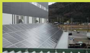
太陽電池パネル
